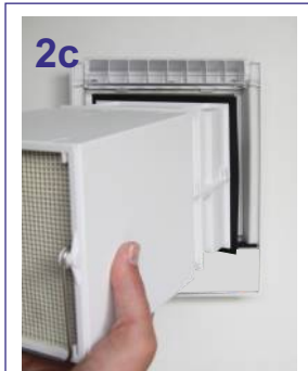
Systemträger in die Wand einschieben
