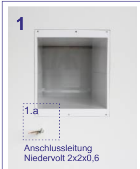
Wand-Teleskopeinheit und Netzanschluss sind vorbereitet
