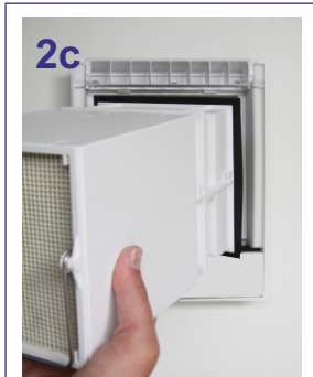
Systemträger in die Wand einschieben
