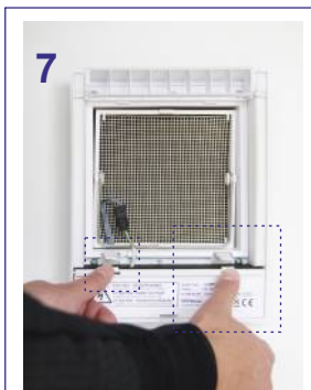
Elektrodeckel schließen
