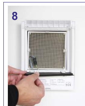
Trennsteg-Abdichtung einsetzen
