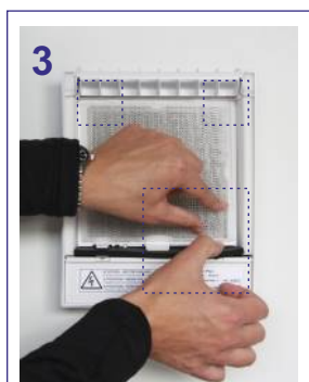
3 Filter in Aufnahme stecken; hinter beide Laschen klipsen
