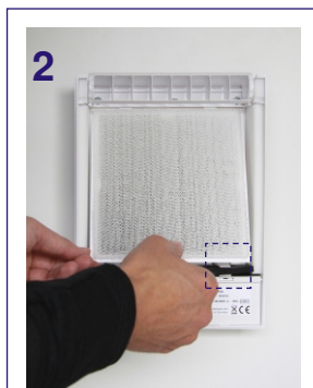
2 Filter an den beiden Laschen entriegeln und entnehmen
