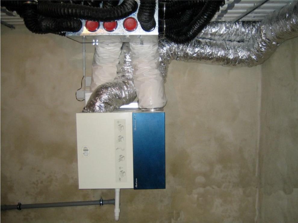
Gerätezentrale (hier im Untergeschoss): Wandhängendes Lüftungsgerät mit Schalldämpfer und Kondensatanschluss.
