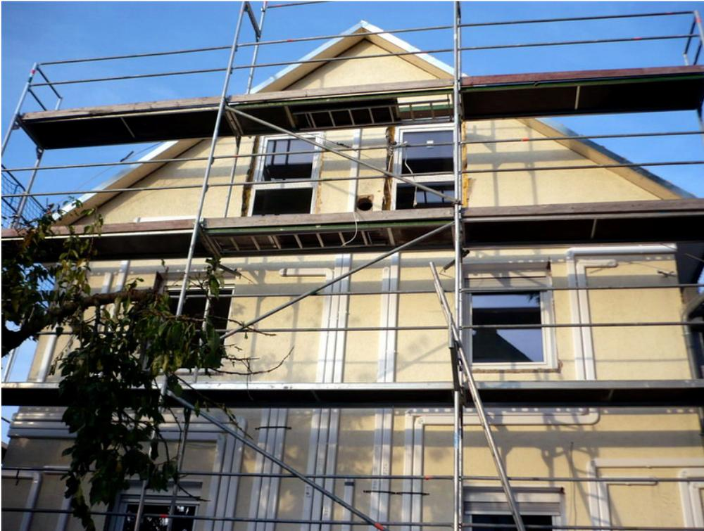
Ein hoher Dämm- bzw. Dichtigkeitsstandard wird am Bestandsgebäude durch den Einbau neuer Fenster und das Anbringen einer hochwertigen Fassadendämmung erzielt. Um das zu sanierende Gebäude gegen möglichen Schimmelbefall (durch unzureichende Lüftung bei dichtem Gebäudekörper) zu schützen wird eine kontrollierte Wohnraumlüftung integriert. Die Lüftungskanäle werden vor den Dämm-Maßnahmen auf der Aussenfassade installiert.
