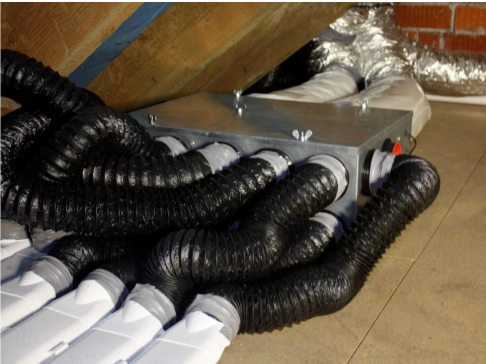
Die Verteiler-Kombibox ist die zentrale Verteil- und Sammelstelle aller Lüftungsleitungen (hier im Dachboden)
