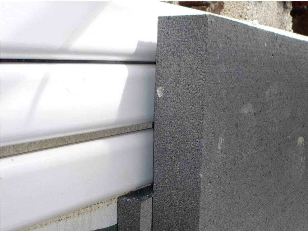
Ebenso kann eine zweischichtige Dämmung eingesetzt werden. Die erste Schicht wird dann in Kanalstärke (ca. 45-50mm) gewählt. Die Vorgehensweise erfordert auf jeden Fall eine Abstimmung mit dem Fassadensanierer!
