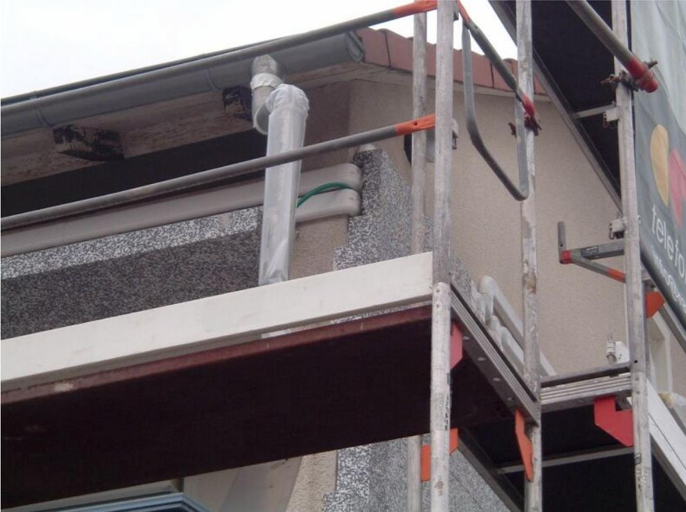
Nach der Installation der Lüftungskanäle wird die Fassadendämmung aufgesetzt. Die Dämmung wird entsprechend ausgeschnitten.
