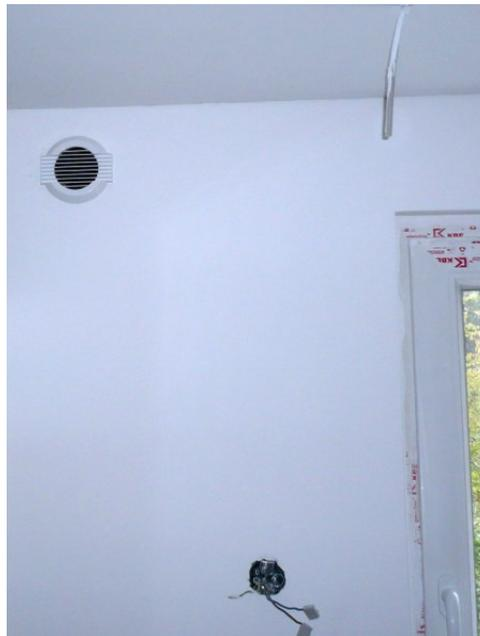
Für die Hauseinführung wird ein Wanddurchbruch mit dem Durchmesser 90 mm erstellt und der Anschlußstutzen NW80 für das Ventil eingesetzt. (links)
