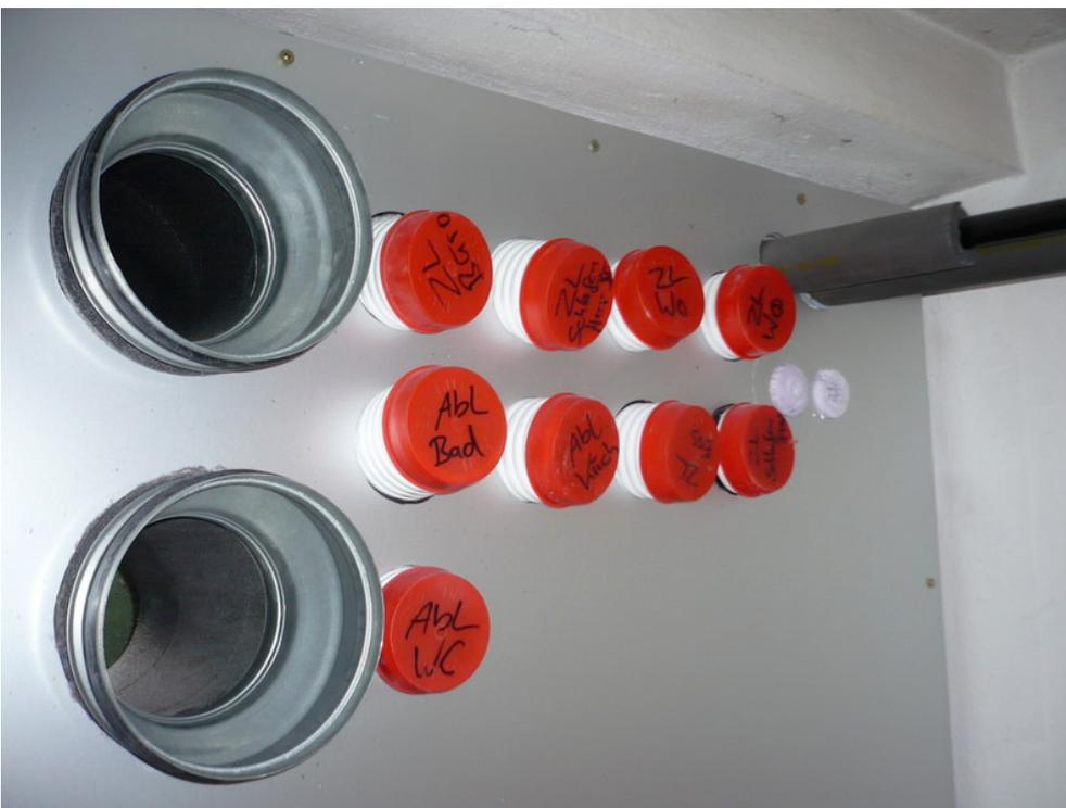
Hauseinführung von innen. Lüftungskanäle, Aussenluft und Fortluftanschlüsse sowie weitere Gewerke werden durch das Fensterpanel geführt.
