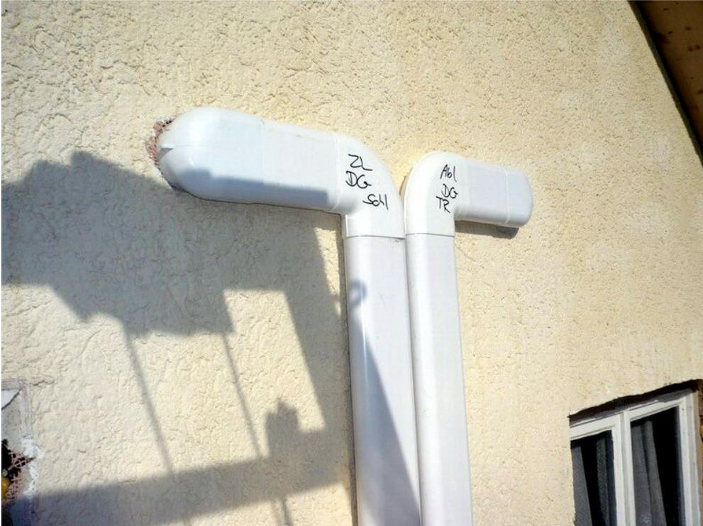
Der Lüftungskanäle werden an die Ventilpositionen (innerhalb des Gebäudes) gebracht.
