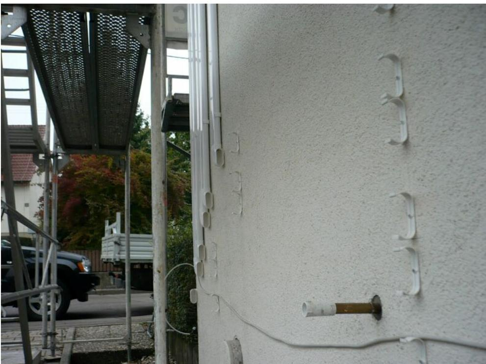
Der Lüftungskanal wird mit Halteklammern um das Gebäude verlegt und mittels Klebstoff oder Klebebänder abgedichtet. Jedes Lüftungsventil wird über einen separaten Kanal mit der Lüftungszentrale verbunden.
