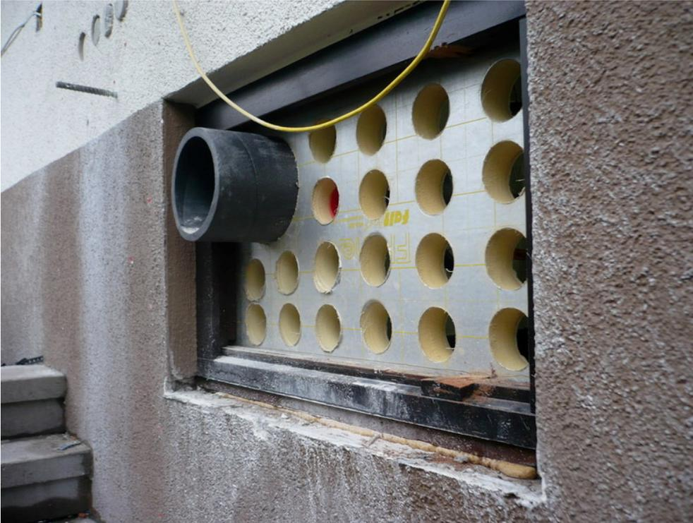
Wird die Lüftungszentrale im Untergeschoss vorgesehen, kann die Hauseinführung über ein nicht mehr benötigtes Kellerfenster erfolgen.
