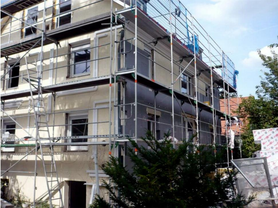
Die Fassadendämmung wird um das Gebäude komplettiert, danach kann die Fassade verputzt werden.
