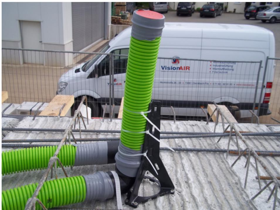
Die Einlegerohre werden ca. 40cm über Rohdecke abgeschnitten und mit einem Verschlussdeckel versehen. An der Schnittstelle wird später ein Übergangsstück auf Flachkanal (100x40mm) aufgesetzt.
