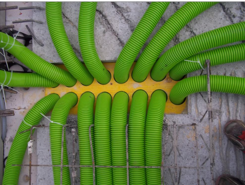
Einführung der Einlegerohre in den Schacht zur Weiterführung in den Technik-raum.
