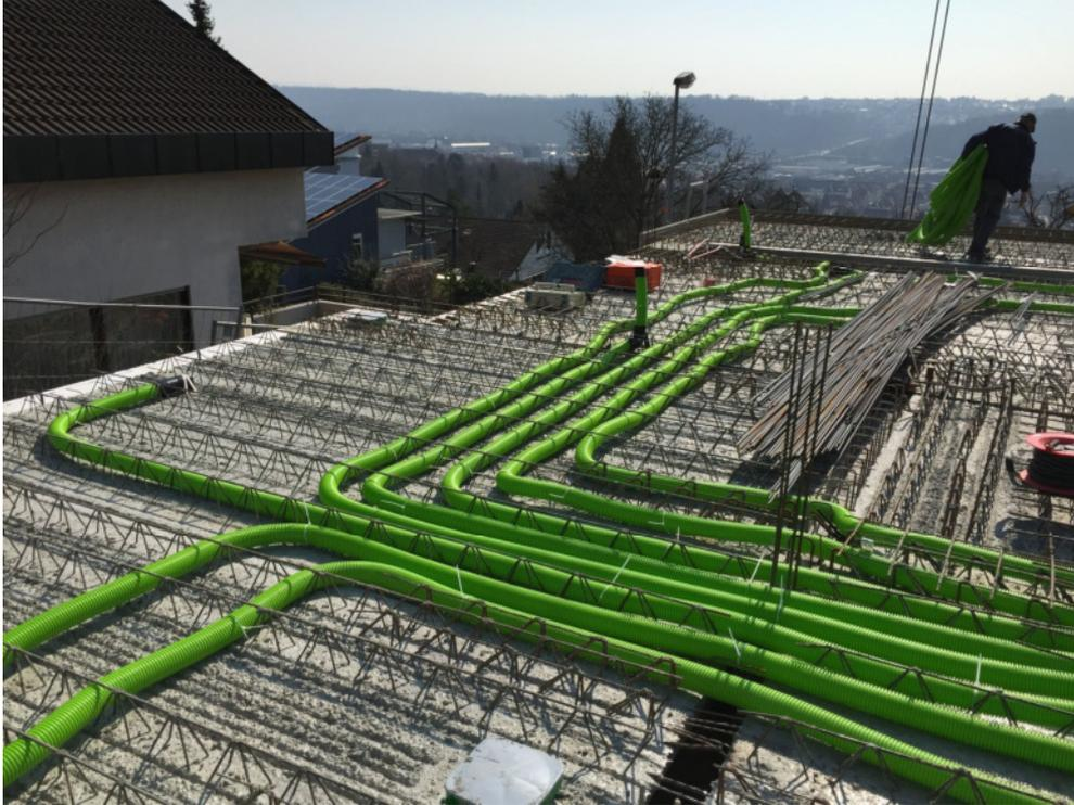
Der Vorteil des Einlegesystems liegt in der schnellen und einfachen Lösung zur Installation einer Be- und Entlüftungsanlage in Neubauten.
