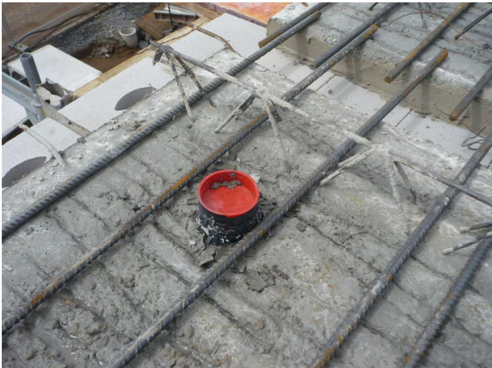
**Unsere Ventilmanschetten, können vorab vom Deckenplattenhersteller gemäß Planung positioniert und eingegossen werden.**
