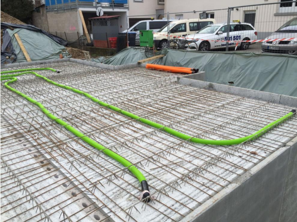
Die Einlegerohre werden mit kräftigen Kabelbindern an die Trägereisen befestigt. Das verhindert ein Verschieben oder Aufschwimmen der Rohre beim Eingießen und Rütteln des Betons.
