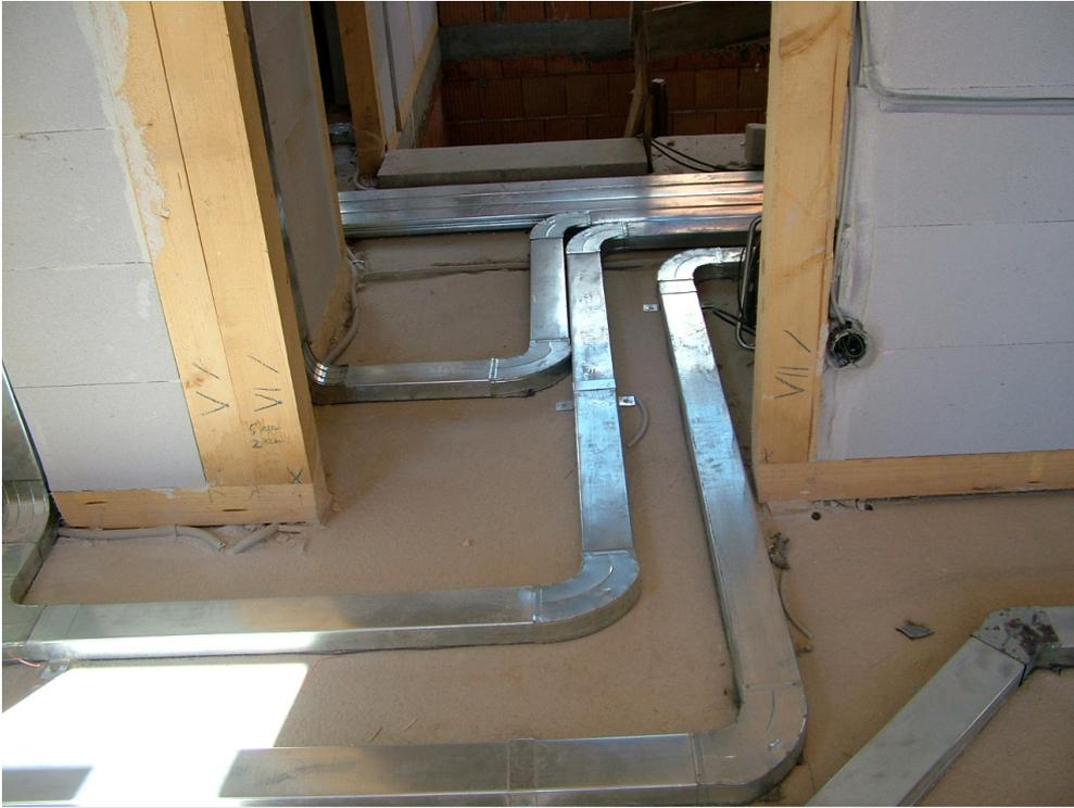
Die MINI – Flachkanäle aus verzinktem Stahlblech mit einer Breite von 100mm und einer Höhe von 50mm werden in Längen zu vier Metern geliefert und auf der Baustelle bedarfsgerecht zugeschnitten.
