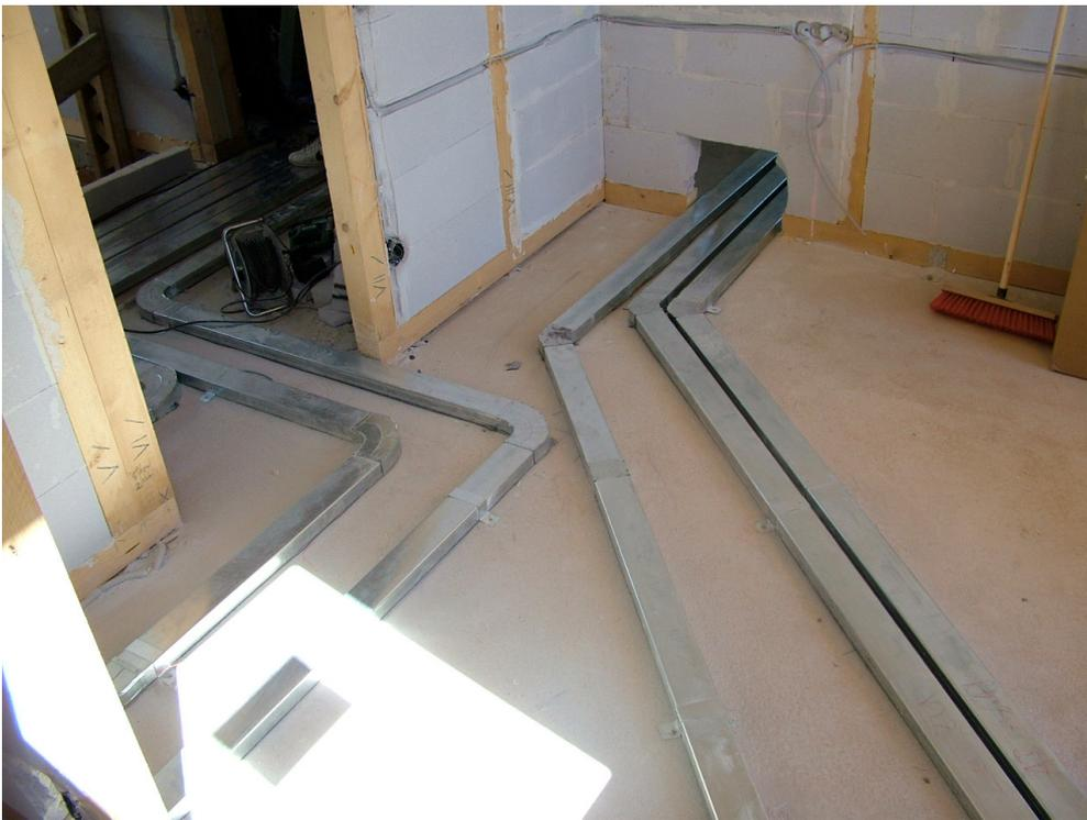
Zur Verbindung von 2 MINI – Flachkanälen werden Verbindungsschlösser geliefert, so daß auch größere Leitungslängen problemlos montiert werden können.
