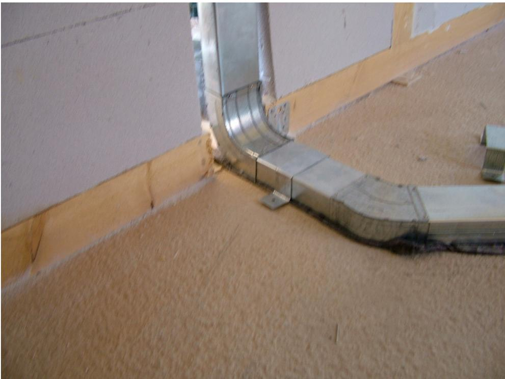
Hier im Bild zu sehen ist eine andere Variante eines Wandanschlusses, dieser wurde mit einem 45° Flachbogen angeschlossen.
