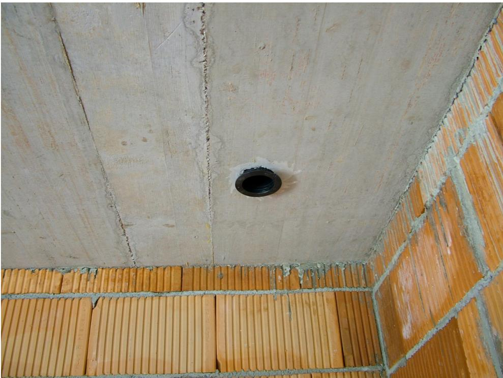
Die Zu- und Abluftmanschette wird durch die Decke geführt, diese kann wahlweise verlängert werden mit optionalen Ringen.
