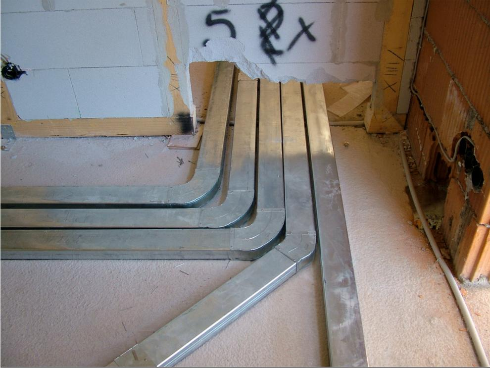
Damit das MINI – Flachkanalsystem bei Einbringen des Estrichs nicht verschoben werden, müssen diese mit Hilfe von Niederhaltern befestigt werden.
