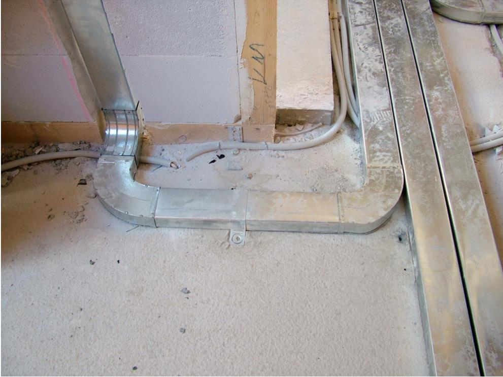
Hier im Bild zu sehen ist der Anschluß eines Wandaustrittes mittels eines 90° Flachbogens für Zu- oder Abluft.
