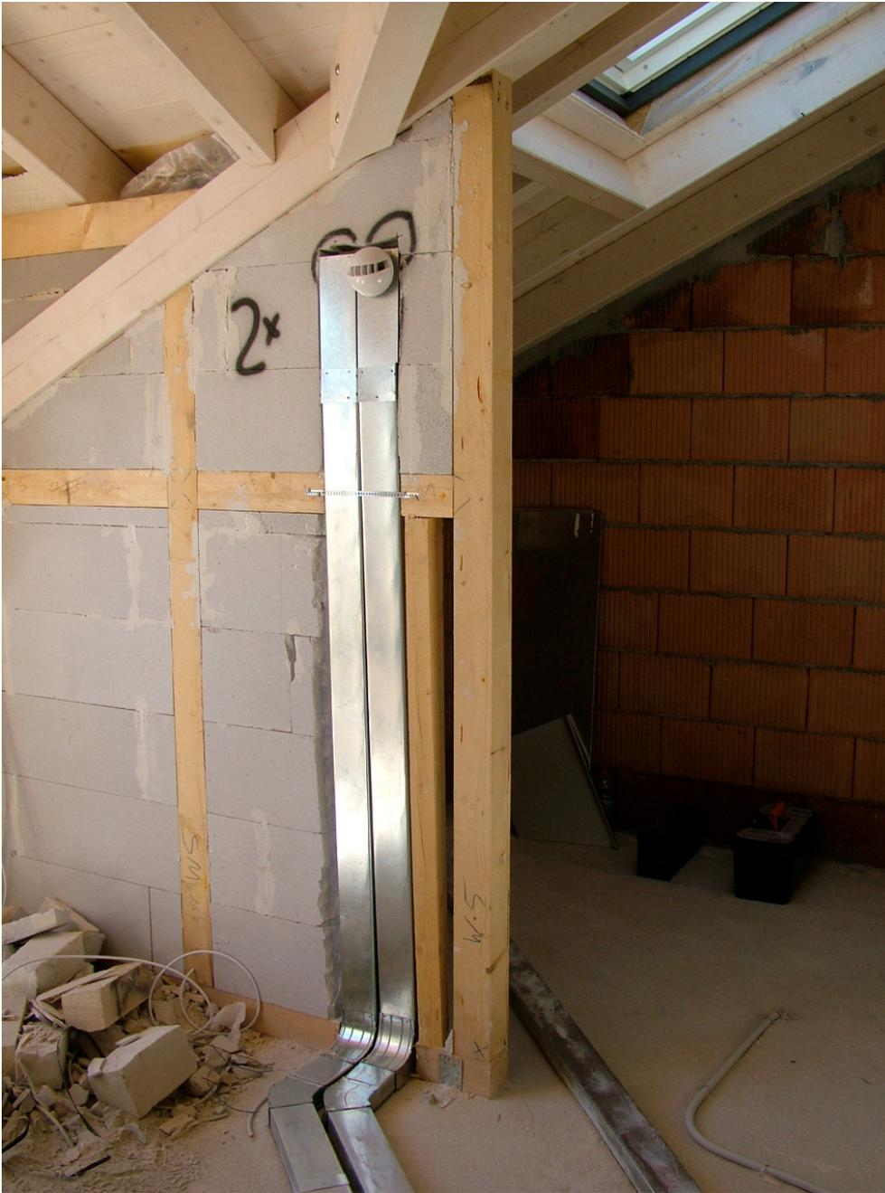
Hier im Bild zu sehen ist ein Doppelwandanschluß für 2 hintereinander liegende Räume – im Vordergrund ist eine Zuluftleitung und im Hintergrund befindet sich eine Abluftleitung.
