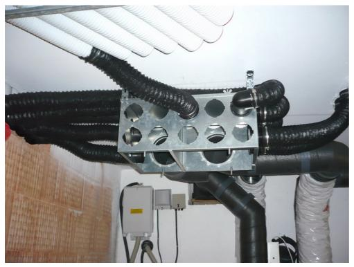
Der Flex-Laminatschlauch kann zur Reinigung oder zur nachträglichen Installation von KVR oder Zusatzschalldämpfern wieder gelöst werden.
