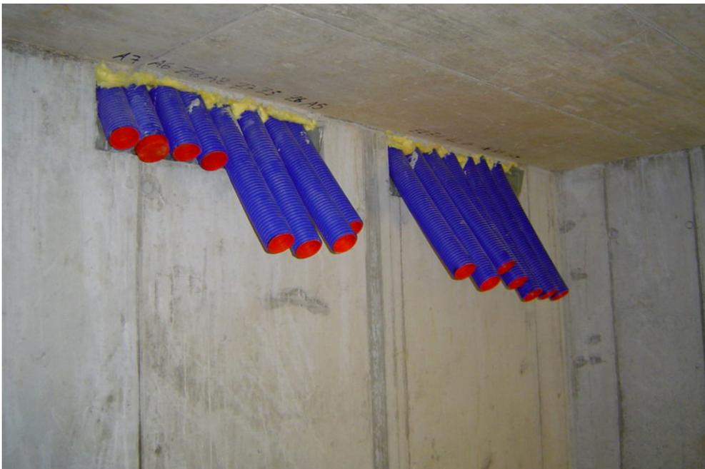
Seitliche Einführung der Einlegerohre aus senkrechten Steigschächten. Die Rohre sind zum Teil auf Fertigmaß gekürzt und mit Schutzdeckel gegen Verschmutzung versehen.
