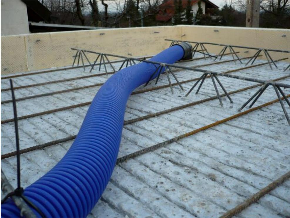
Die Einlegeschläuche sind bei der Installation an die Trägereisen zu befestigen. Dies verhindert ein Verschieben oder Aufschwemmen der Rohre beim Einbringung des Betons.
