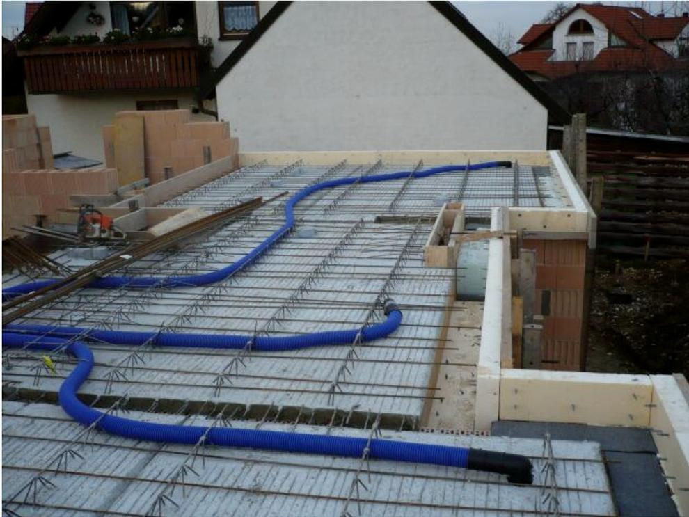
Der Vorteil des Einlegesystems liegt in der schnellen und einfachsten Lösung zur Installation einer Lüftungsanlage in Neubauten.
