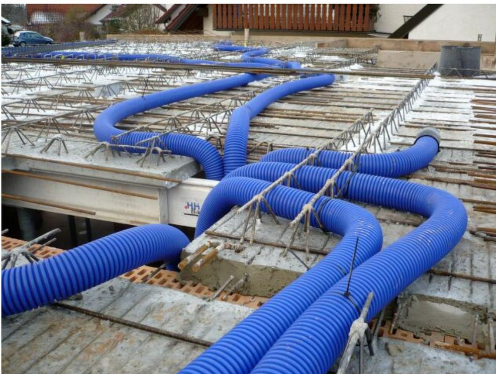
Bei der Herstellung der Fertigdeckenplatten ist auf ein Mindestabstand von 85mm zw. Trägereisen und Betonplatte zu achten, so daß die Einlegeschläuche dazwischen eingeschoben werden können.
