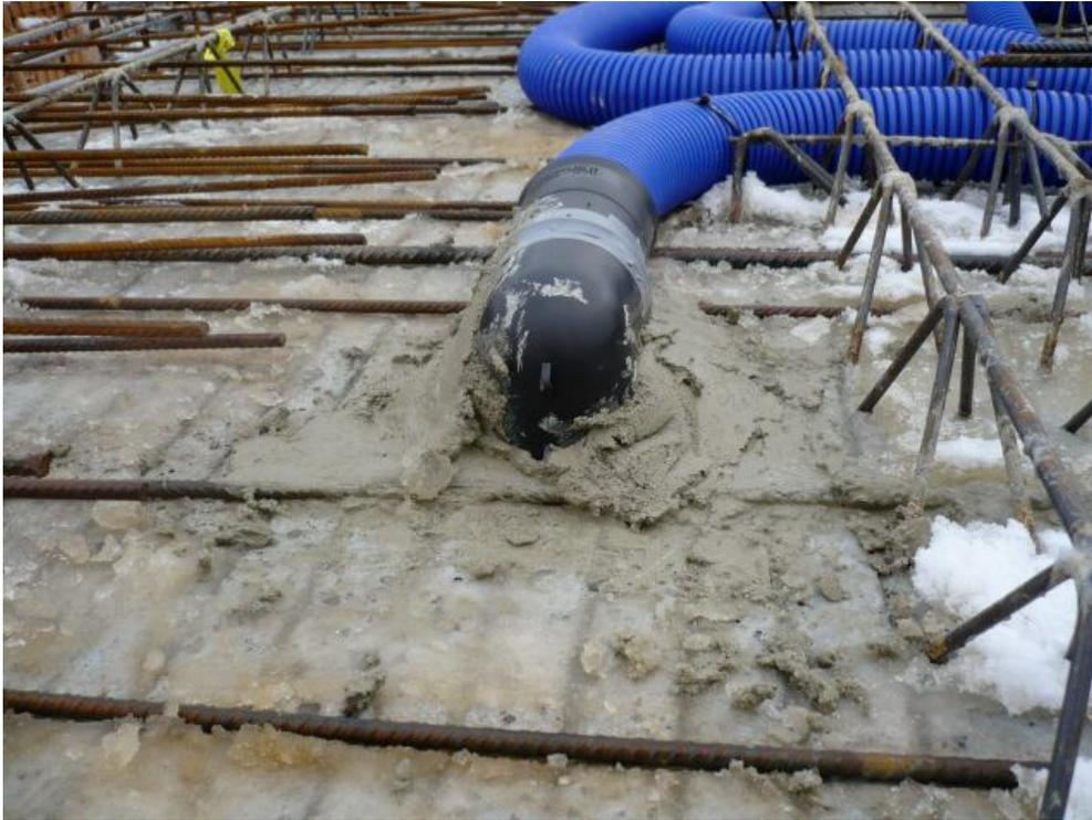
Der Ventilanschluß wird an der vorgesehenen Aussparung positioniert und mit einem Schalbrett mit Spieß unterhalb der Decke gesichert.
