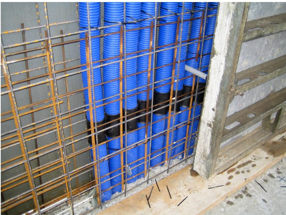
Im Steigschacht werden alle Leitungen zusammengeführt und zur Verteiler-Kombibox geführt (in der Regel im Technikraum).
